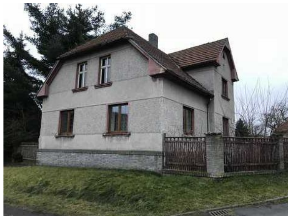
Pohled na RD.
