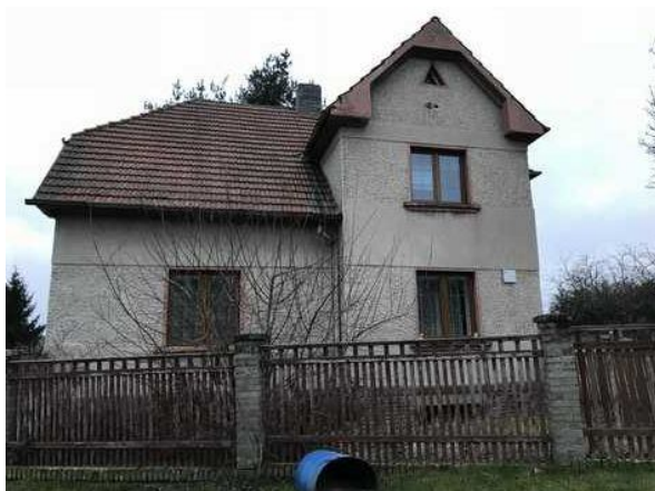
Pohled na RD.
